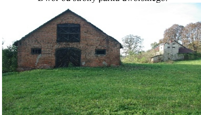
Budynek chlewni, w tle niszczący spichlerz.
