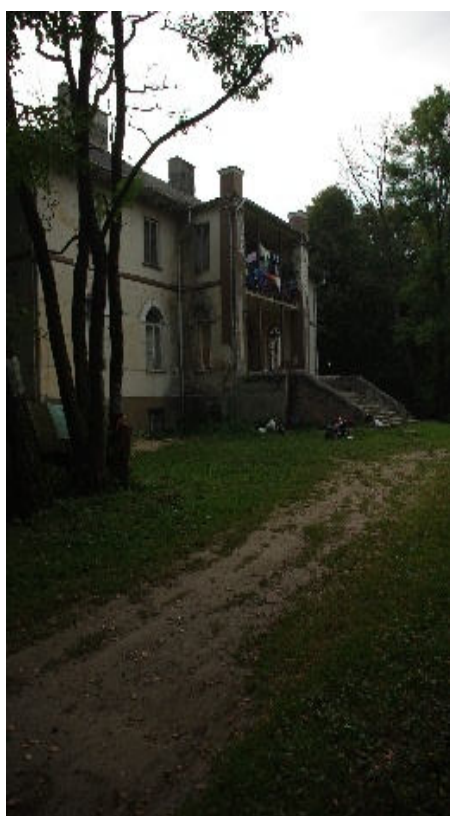
Dwór od strony podwórza.
